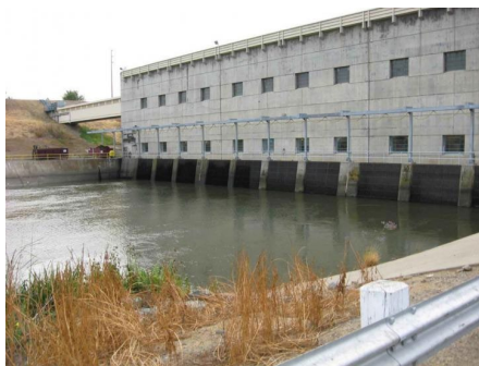
Une station de pompage de rivière
