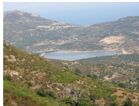
Un barrage en Haute-Corse
